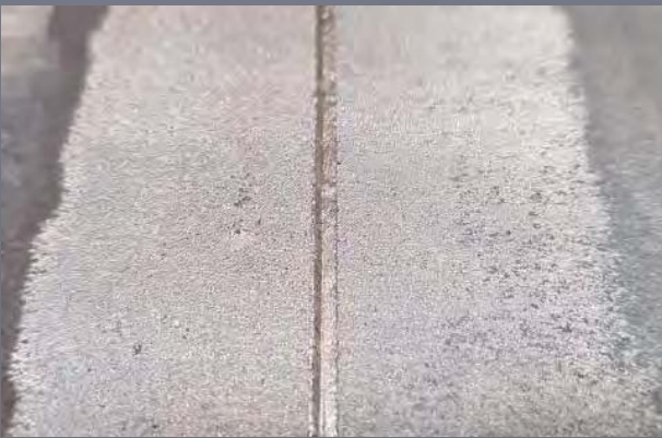
鐸接大型薄鋼板
