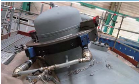
TT508切割開槽機與氣動驅動
