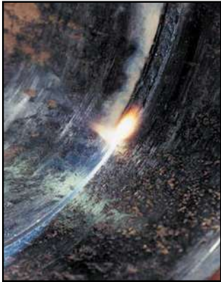
在5G的位置鉚接的8in. x 0.375in.的API 5L-X52管件壁的內部照片。
